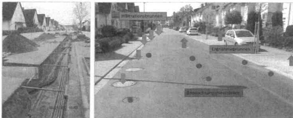
Abbildung 15: links Leitungsbau; rechts ein Teil der fertiggestellten Brunnengalerie für die großtechnische Umsetzung der in-situ Mobilisierung
