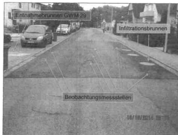
Abbildung 11: Das Pilotversuchsfeld im direkten Abstrom der ehem. Säuregrube
