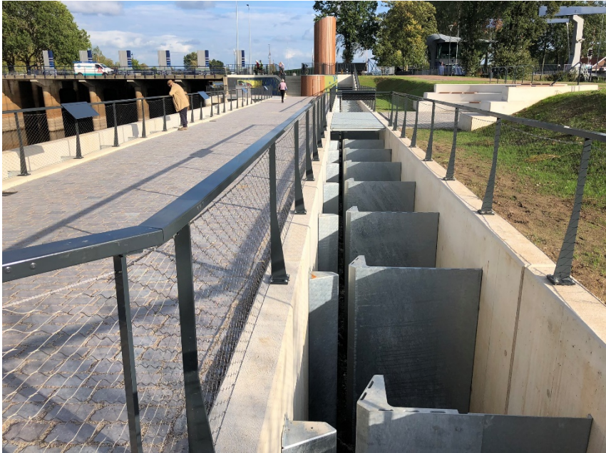
Abbildung 4: Trennwände wurden zur Reduzierung der Bauwerkslänge in Stahlbauweise ausgeführt (Bild: Redeker, 27.09.2019)
