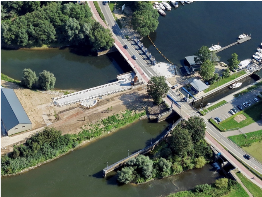
Abbildung 1: Luftbild der Staustufe Doesburg mit 5-feldrigem Wehr, fertiggestellter Fischaufstiegsanlage, Schleuse und Vorfluter (am unteren rechten Bildrand) (Bild: Waterschap Rijn en Ijssel)
