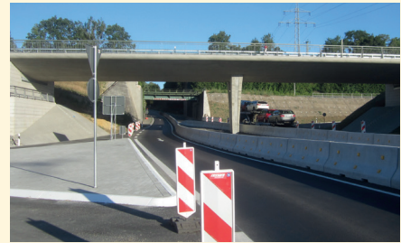
B14, NEUBAU ANSCHLUSSSTELLE BACKNANG-MITTE
