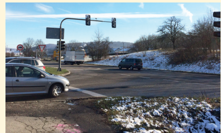
B 29, AUSBAU ESSINGEN-AALEN
