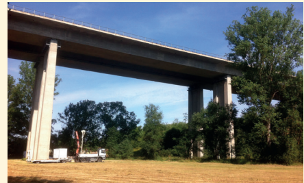
A 7, ERNEUERUNG WERTALBRÜCKE
