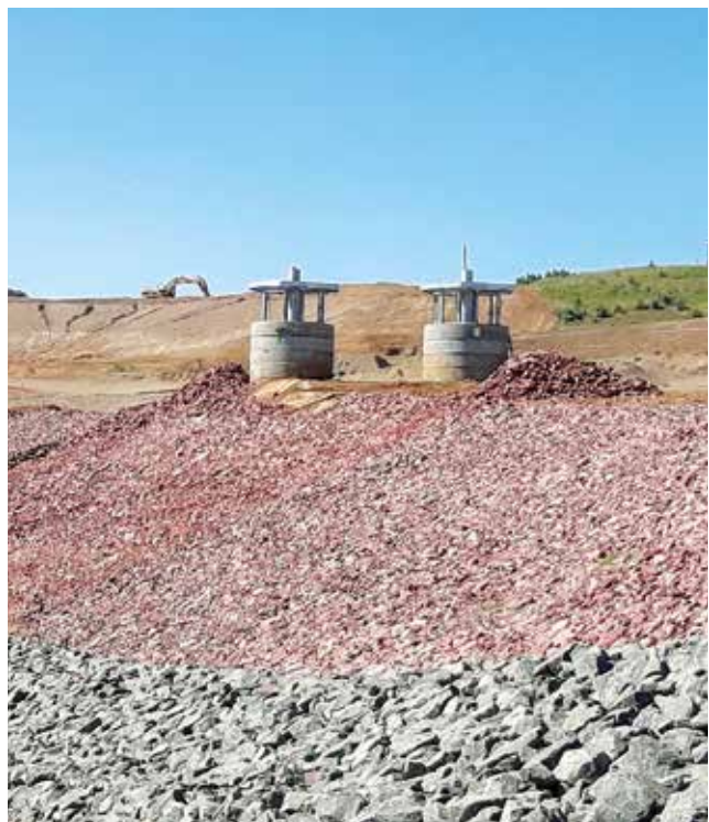
Foto 13: Stützbauwerke zur Verlängerung der Grundwassermessstellen
