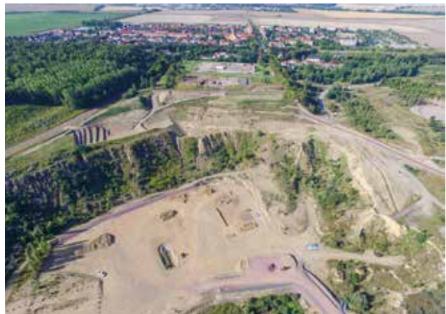
Foto 6: Sanierungsstand nach der Verfüllung der beiden Restseen
