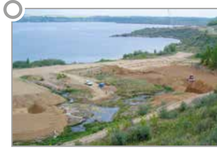
Aufbau einer Arbeitsebene +90 m NHN im Haupttrutschungskessel
