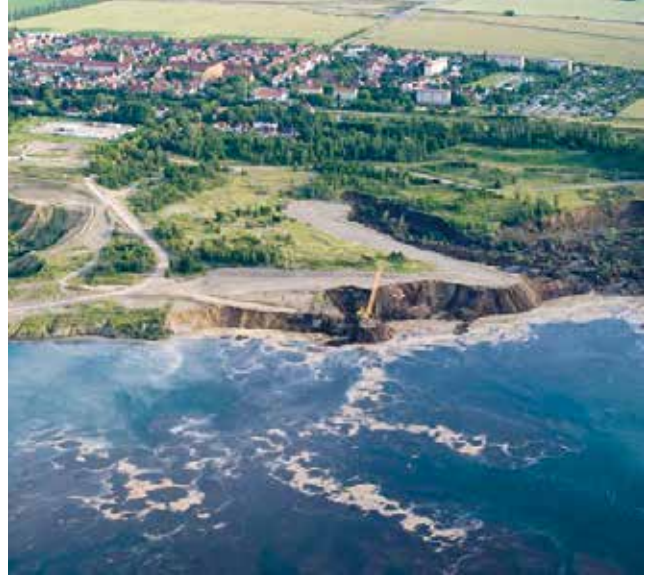
Foto 15: Situation unmittelbar nach der Setzungsfließrutschung vom 28.06.2016
