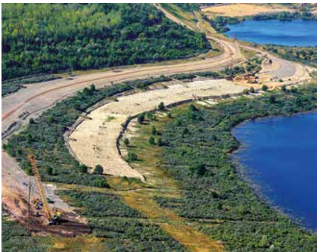
Foto 18: Herstellung der Rütteldämme im südlichen Abschnitt
