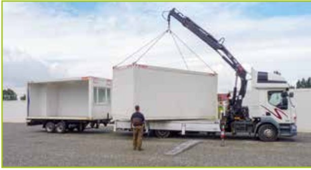
Errichtung der Tagesanlagen mit Büro- und Sanitärcontainern für Behörden, Ingenieur-Büros und LMBV
