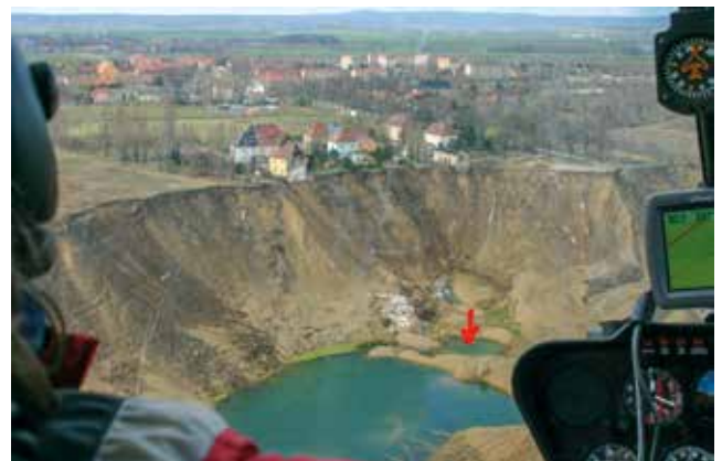
Foto 10: Blick in den Rutschungskessel mit Wasseransammlungen, 2010
