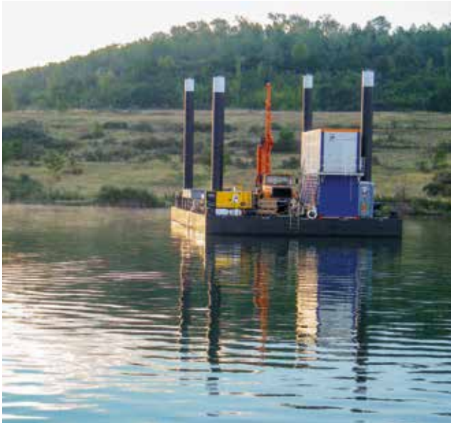
Foto 2: Arbeitsplattform auf dem Concordia See
