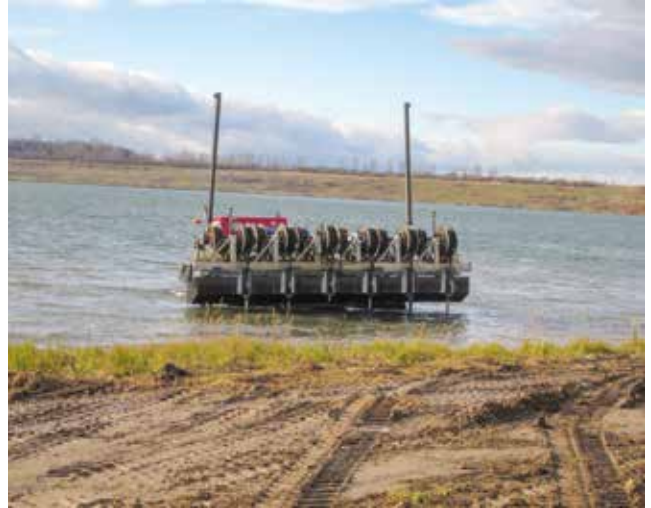
Foto 21: Leichte Rütteldruckverdichtung zur Herstellung der Trittsicherheit
