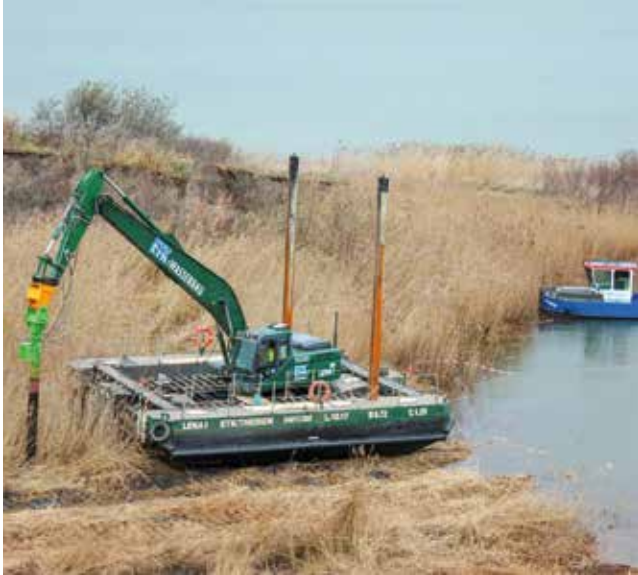
Foto 14: LRDV-Maßnahmen im kleinen westlichen Rutschungskessel
