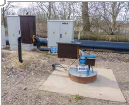
Fertigstellung und Inbetriebnahme des Brunnenriegels Südwestböschung
