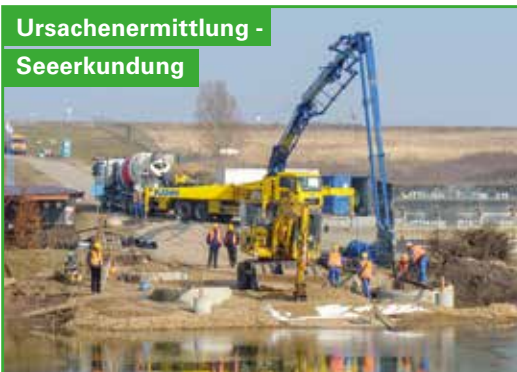
Errichtung Kranaufstandsfläche am Schadelebener Ufer
