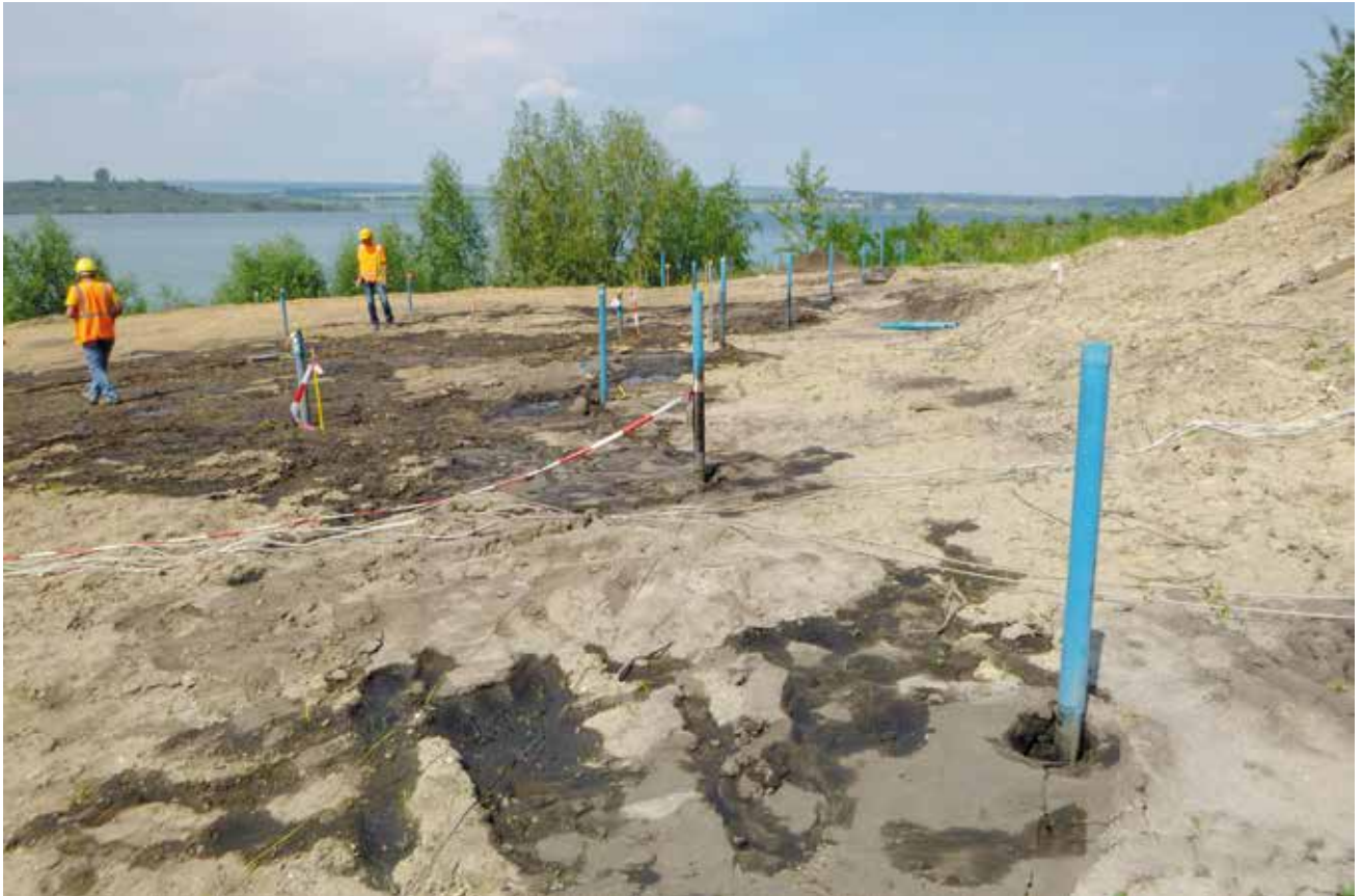
Foto 2: Sprengbohr- und Perforationsbohrlöcher am östlichen Rand der Sprengfeldfläche
