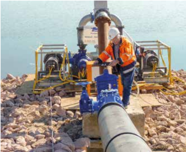
Foto 11: Wasserhaltung zur Ableitung in den Hauptseegraben
