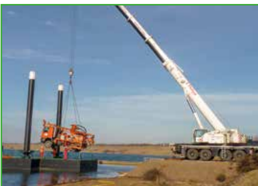
Einheben von Bohrgerätetechnik auf die Pontons
