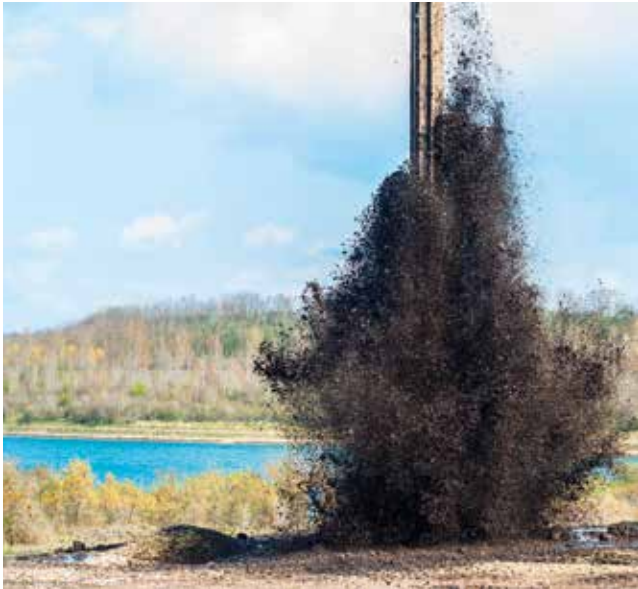
Foto 3: Rüttelstopfverdichtung im Bereich der Ostböschung, Nordbereich
