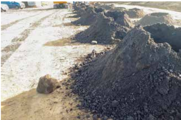
Foto 5: Vorbohren der RDV-Ansatzpunkte auf der Altablagerung
