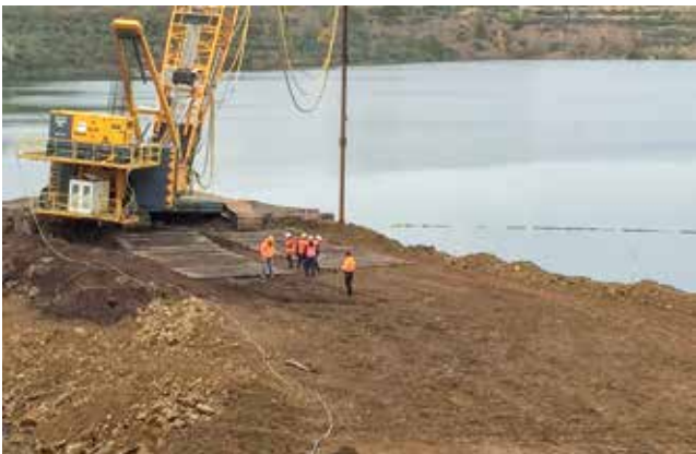
Foto 12: Endabnahme der Rampe und des Trägergerätes vor dem Bergungsbeginn
