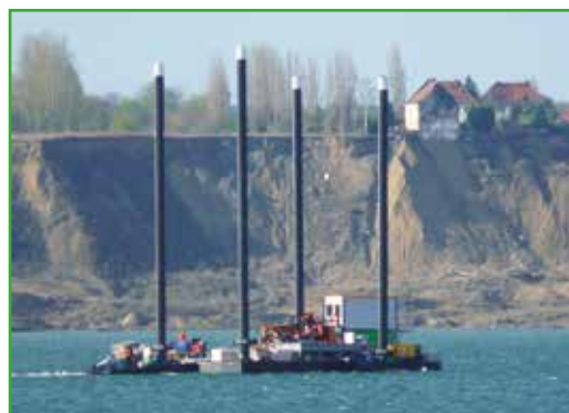
Im Einsatz befindliches Ponton vor dem Hauptrutschungskessel
