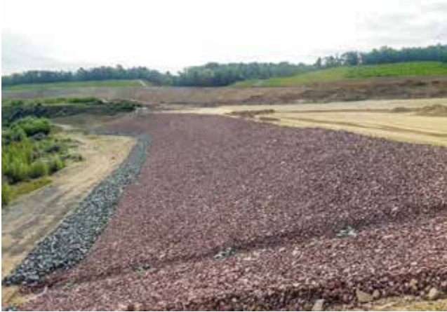
Foto 9: Böschungssicherung unterhalb +100 m NHN im Bereich Hauptrutschungskessel
