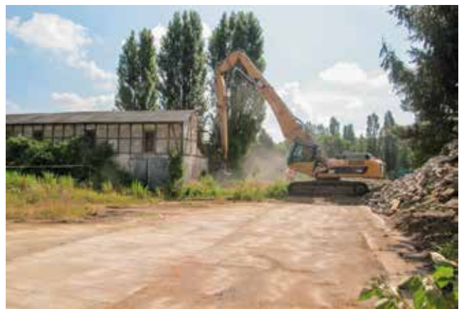
Foto 2: Einsatz Longfrontbagger im Zuge Abbruch der Gebäude an der Abbruchkante
