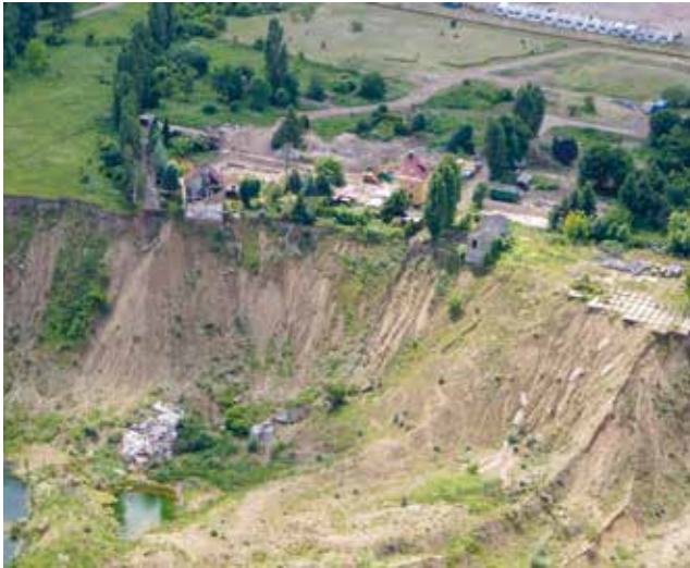
Foto 3: Abbruch Siedlung „Am Ring“
