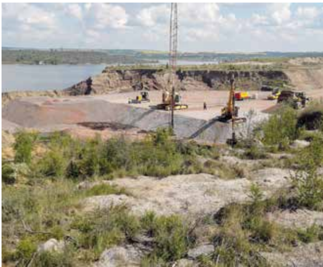
Foto 17: LRDV und Herstellung Dränageschicht im Bereich der SW-Böschung
