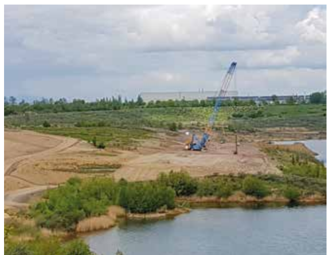
Foto 10: Rüttelstopfverdichtung im Bereich der RDV-Körper Altablagung
