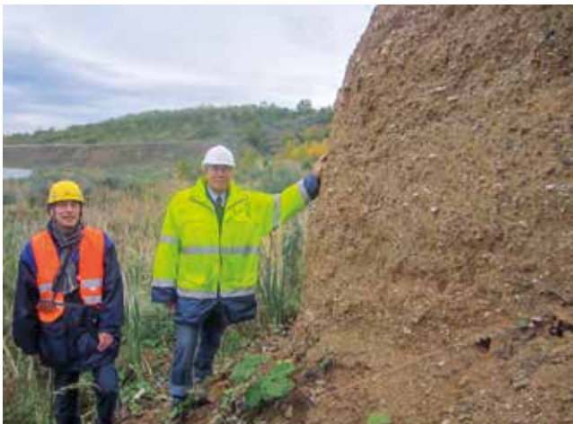
Foto 7: Prof. Dr.-Ing. Katzenbach und der Leiter der Projektgruppe der LMBV Dirk Henssen bei einer Begehung des Schadensbereiches
