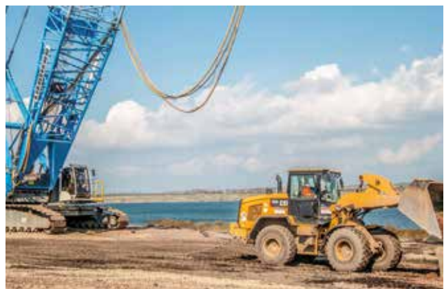
Foto 4: RSV an der Ostböschung im Nordbereich
