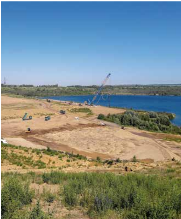
Foto 8: Aufbau Stützkörper außerhalb der Flächen der T-SSPV
