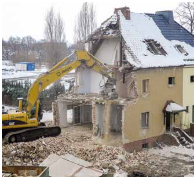
Foto 13: Abriss der Häuser der Siedlung „Am Ring“
