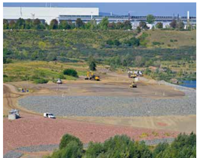
Foto 12: Herstellung Aufschüttung Altablagerung
