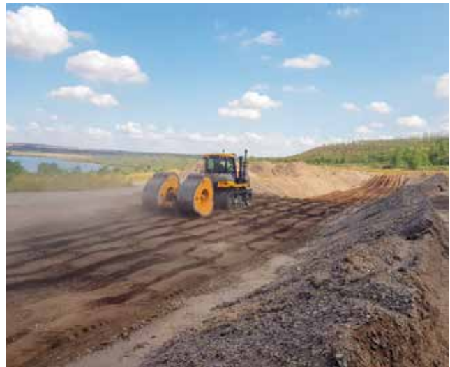
Foto 20: Oberflächennahe Nachverdichtung mittels LandPac-Verfahren im Testfeld
