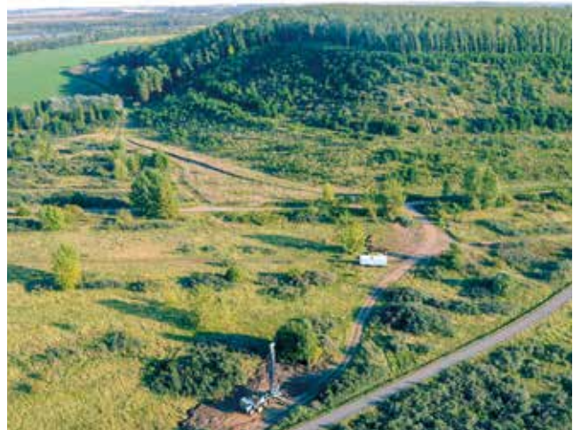
Foto 20: Bohrergerät im Bereich Ostböschung beim Teufen einer Grundwassermessstelle
