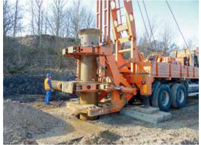
Foto 9: Bohrarbeiten Filterbrunnen im Bereich Südwestböschung
