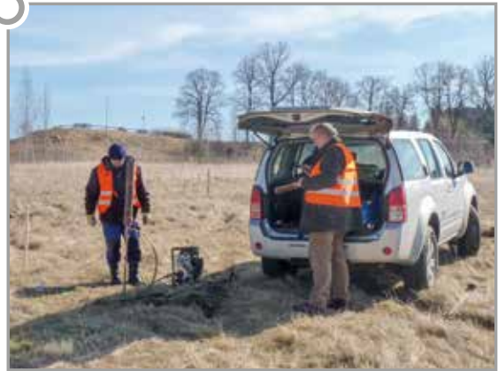
Durchführung von Rammsondierungen
