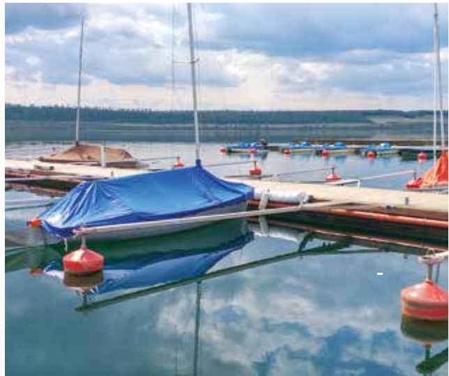
Foto 7: Steganlage mit Bootsanliegeplätzen
