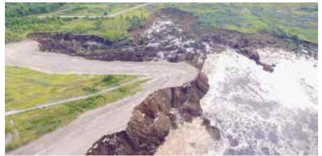
Foto 2: Setzungsfließrutschung vom 28.06.2016 auf der Südwestböschung
