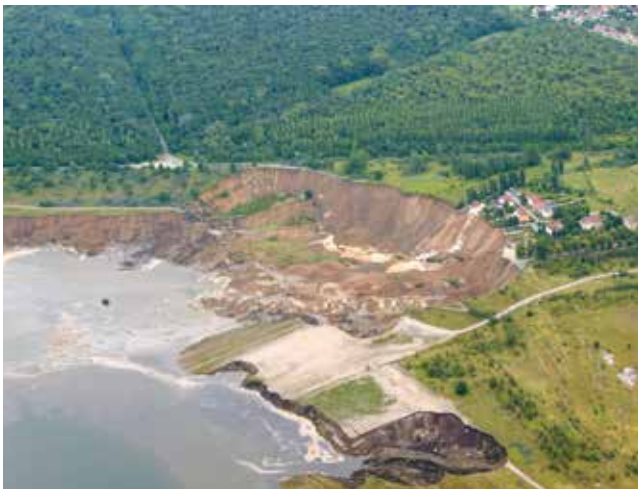
Foto 1: Rutschungskessel vom 18.07.2009 und Siedlung „Am Ring“
