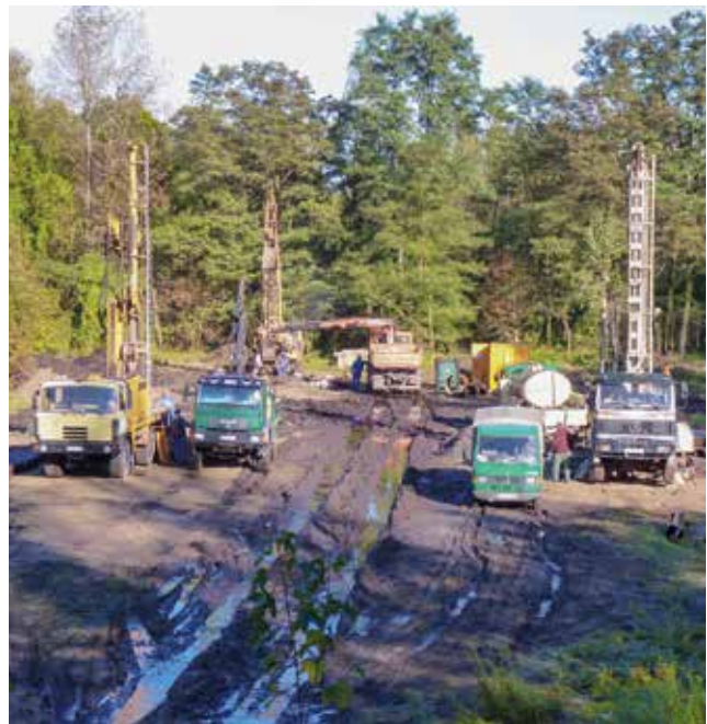
Foto 8: Bohrarbeiten zur Errichtung Brunnen 302 und von Grundwassermessstellen Halde 1 Nachterstedt
