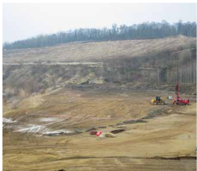
Foto 7: Vorbereitung der Tiefen Schonenden Sprengverdichtung - Herstellung Perforationsbohrlöcher
