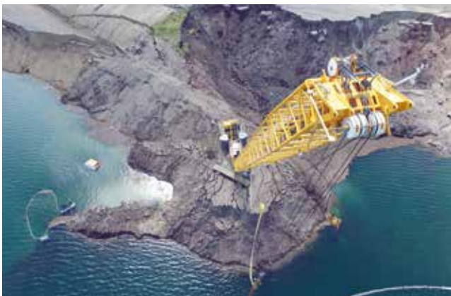
Foto 5: Nachgebrochene Böschungsabschnitte und Trägergerät TG 3 am 07.07.2016 (Quelle: Drohnenbefliegung im Auftrag der LMBV)
