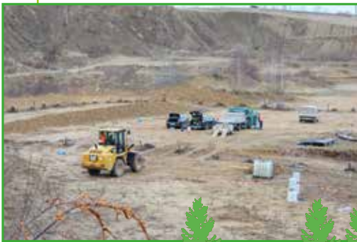
Aufbau einer Arbeitsebene +90 m NHN im Haupttrutschungskessel
