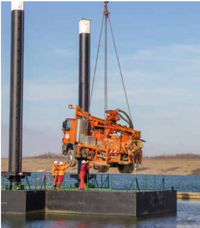
Foto 5: Einheben eines Bohrgerätes
