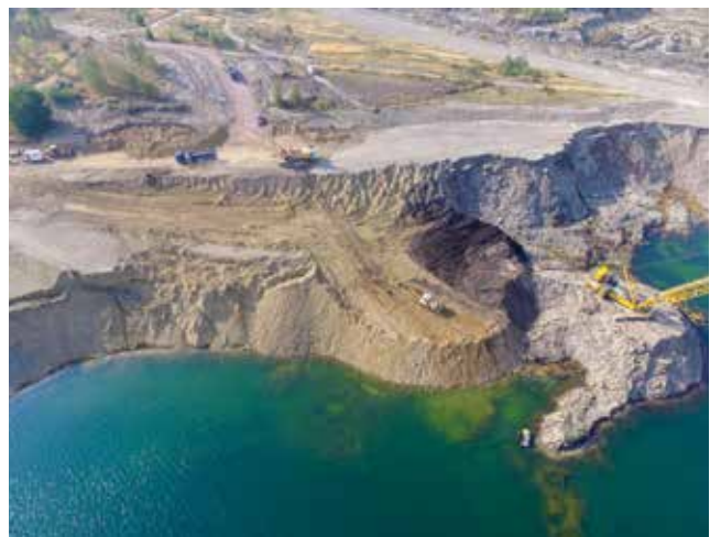
Foto 16: Herstellung Sicherungsdamm als Fahrtrasse für havariertes Trägergerät
