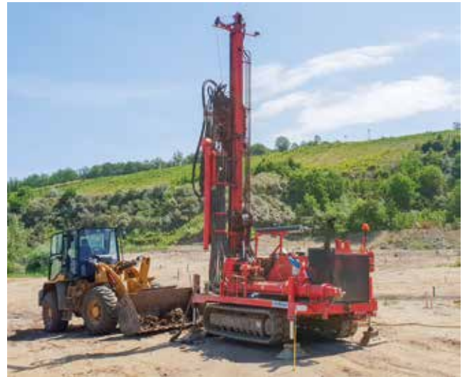
Foto 1: Bohrgerät der T-SSPV im Haupttrutschungskessel Nachterstedt 06/2019
