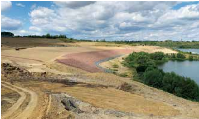
Foto 4: Blick in den sanierten Hauptrutschungskessel Richtung westlicher Teil Ende Juli 2020
