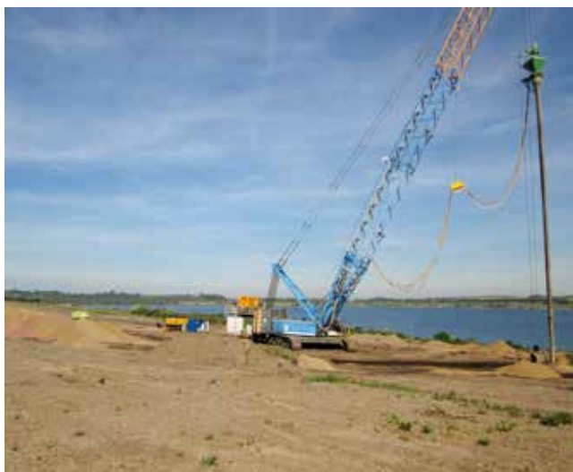
Foto 19: Trägergerät Rüttelstopfverdichtung
