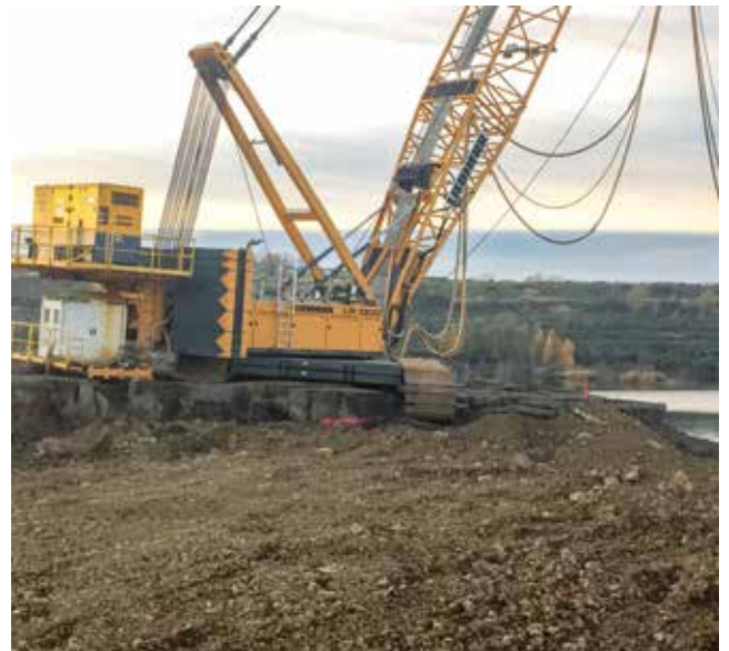
Foto 9: Trägergerät vor dem Freilegen der Fahrwerke
