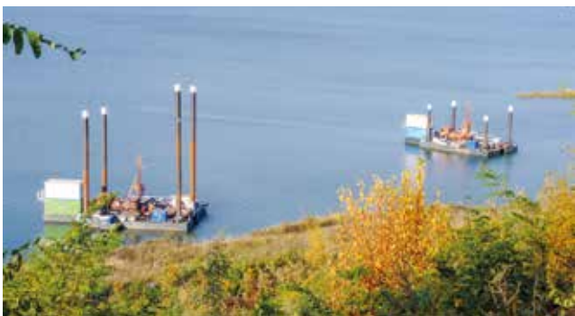
Foto 19: Bohrergeräte auf Ponton im Bereich der östlichen Rutschungsflanke
