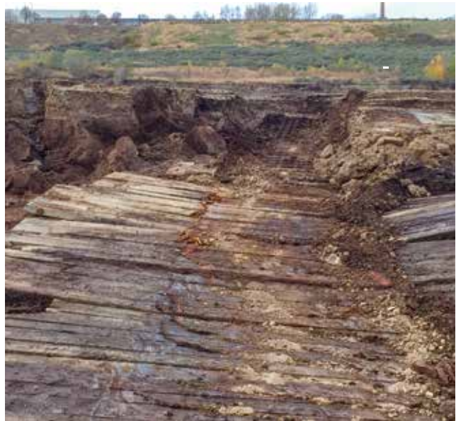
Foto 13: Stapelschwellen nach der Überfahrt mit dem Trägergerät
