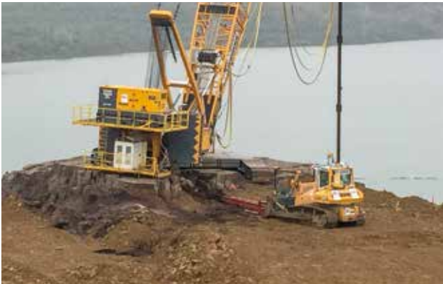
Foto 11: Ferngesteuerte Raupe mit Stechschaufel beim Freilegen der Fahrwerke vom Trägergerät
