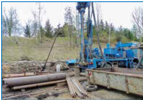
Errichtung des Entwässerungsbrunnen 304
