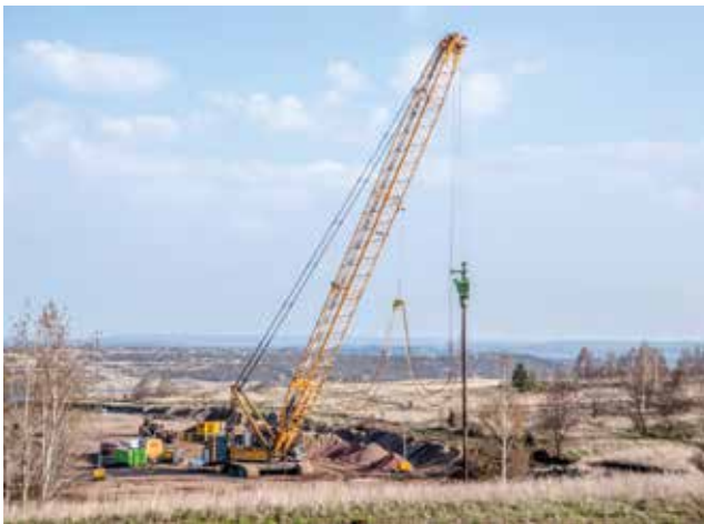
Foto 2: RSV Arbeiten auf der Trasse +103 kurz vor dem Abbruch der Arbeiten
