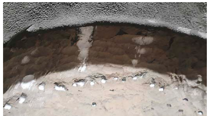
Bild 3 Gefrorene Streifen in der Firste deuten auf den geringen Abstand der Gefrierrohre zur Ausbruchlinie hin The frozen lines at the crown indicate the close distance of the freezing pipes to the excavation line
