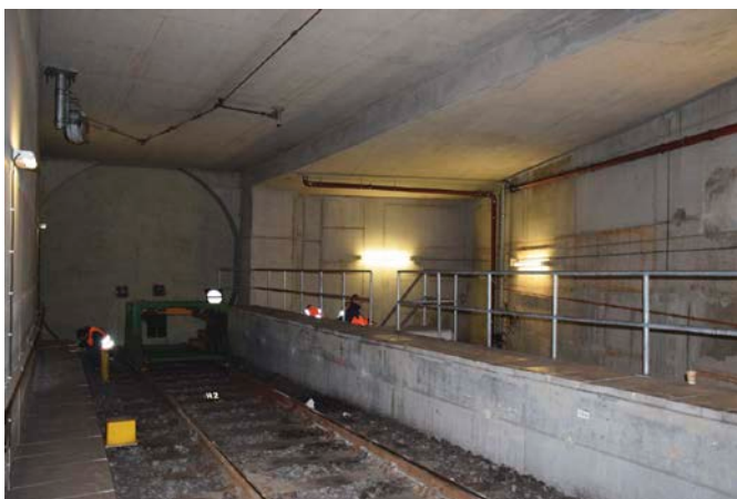
Bild 3 Situation innerhalb des Bestandsbauwerks Situation within the existing tunnel
