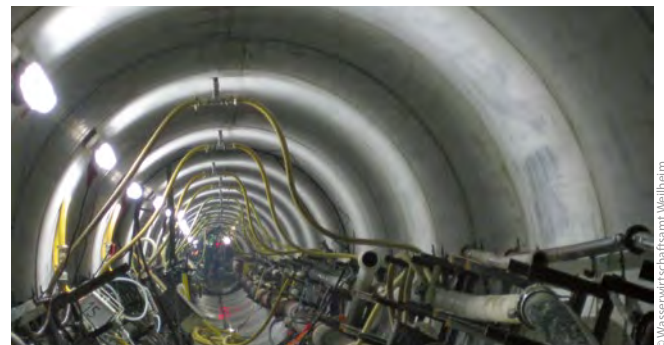
Bild 7: Stollenvortrieb, Laser, Transport- und Versorgungsleitungen, die Bentonit-Injektion zur Reduzierung der Mantelreibung erfolgt über die gelbe Injektionsleitung an Firne und Ulmen
