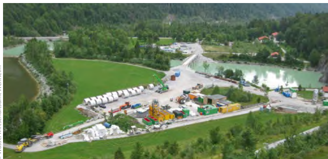
Bild 3: Neue Brücke über den Kolksee, Baustelleneinrichtung und Rohrlager am Fuß des Sylvensteindamms
