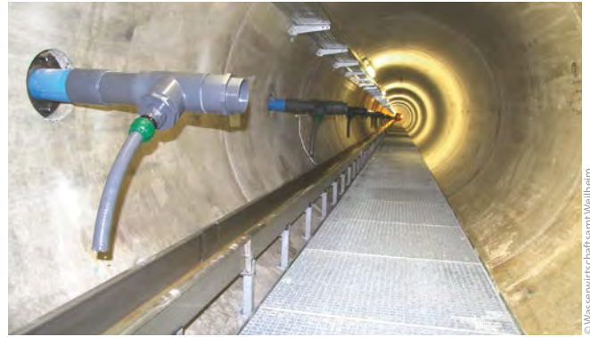
Bild 9: Blick in den Kontrollgang mit Sickerwassersammlersystem und Innenausbau
