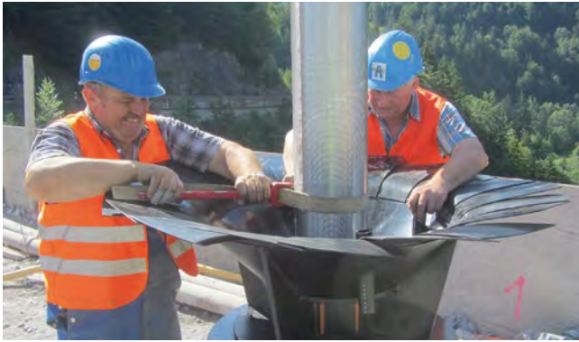
Bild 8: Vorbereitung zum Einbau des Filters (Schlitzbrückenfilter und Sumpfrohr)
