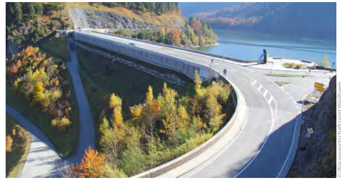
Bild 10: Die neue B 307 mit der verbreiterten Dammkrone im Herbst des Jahres 2015
